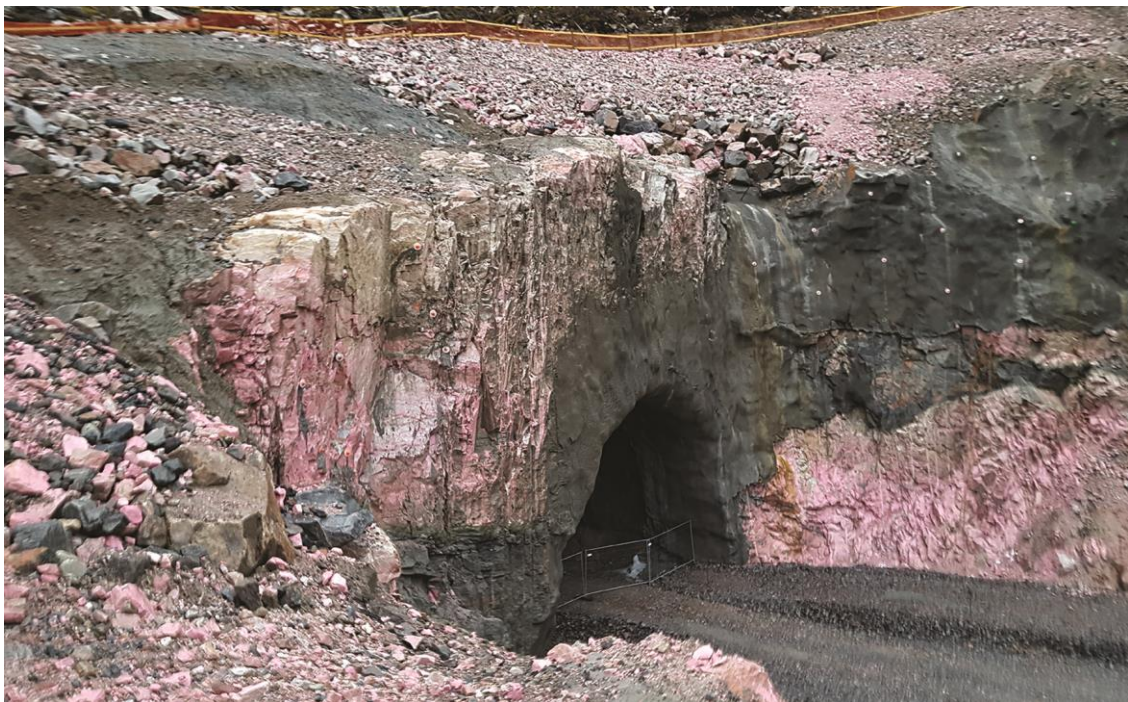
Fig. 3. Sørlig tunnelpåslag med delvis blottet thulitt i stor mektighet, samt sprøytebetong i tunnelen og rundt inngangen.
