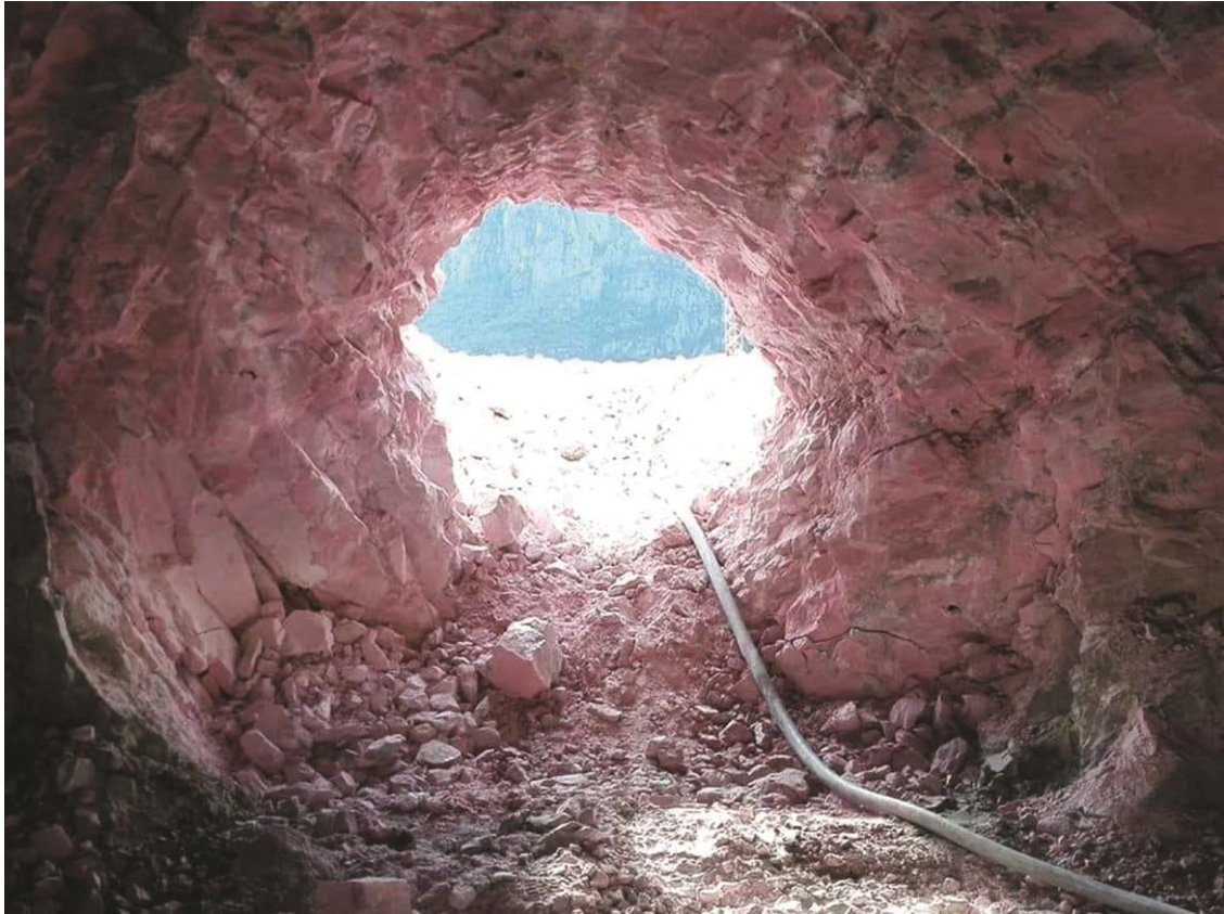
Fig. 2. Gjennomslaget i tunnelen. Foto: Metrostav AS.
