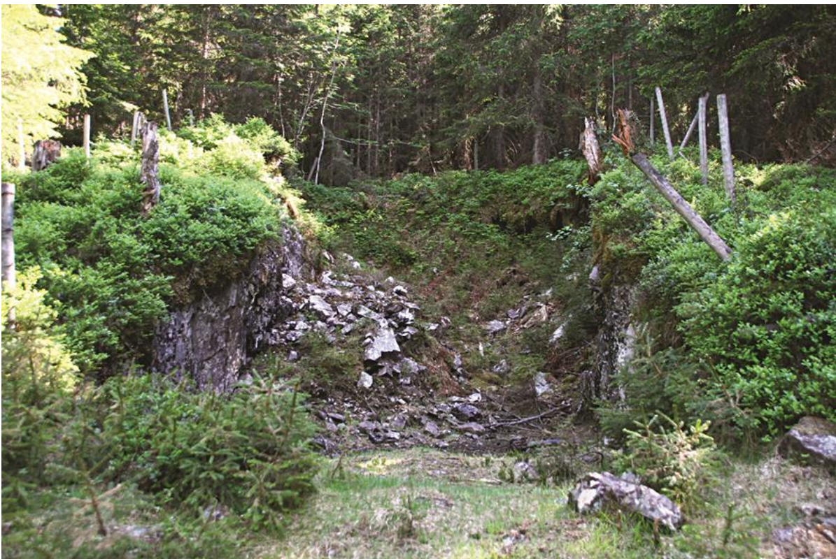
Fig. 2. Et av bruddene ved Skjerpemyr. Massene skjuler en galenittgang med 11 cm mektighet.
