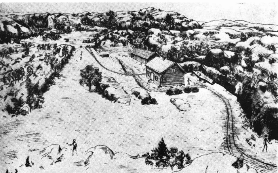
Perspektivtegning, Rømteland. Pegmatitten er innsirklet og ligger i farsundtveggen til høyre for huset. Tegnet av I. Lowsow
