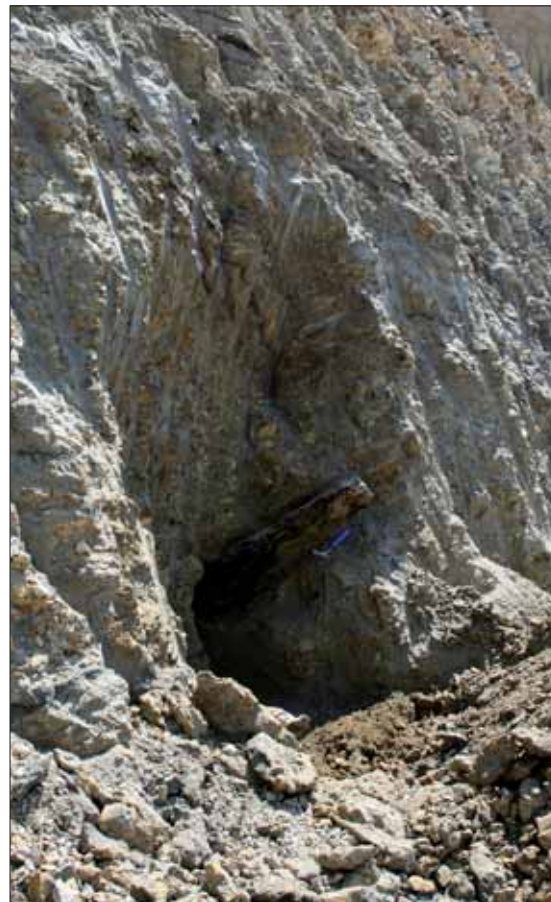
Etter to dagers hugging og 10 minutter med gravemaskinbistand var 1,5 meter synlig.
