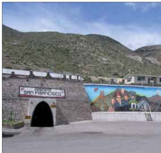
Inngangen til gruva. "Rampa san Francisco", omtrent 5 km å kjøre i spiral for å komme ned. Foto: S.E. Lauritzen.
