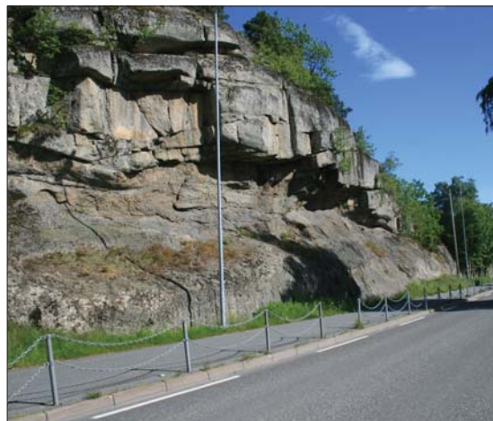
Veiskjæringen ved Buer, Vesterøya i Sandefjord. Foto: Svein A. Berge.
