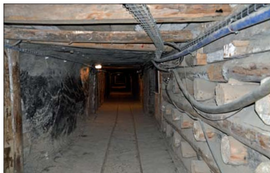
En av de mange gruvegangene støttet opp av tømmer.
