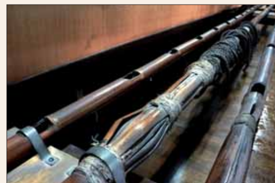
Fortsatt er bambus i bruk når saltlaken skal hentes opp fra de dype «saltgruvene».
