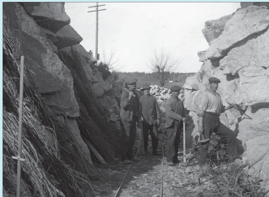
Bilde fra Sukkertoppen tatt ca. 1880 under anleggsarbeider med jernbanen gjennom Sandefjord. Foto utlånt av Sandefjordmuseene, ved Øyvind Thuresson.
