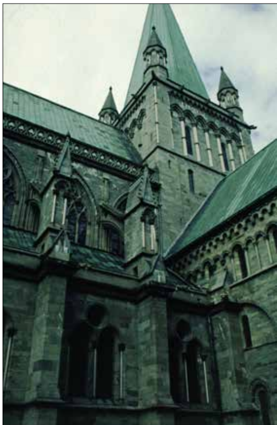
Grågrønn kleberstein og grønnskifer er de viktigste materialene i vegger, søyler og skulpturer i Nidarosdomen. Foto D. Trømborg
