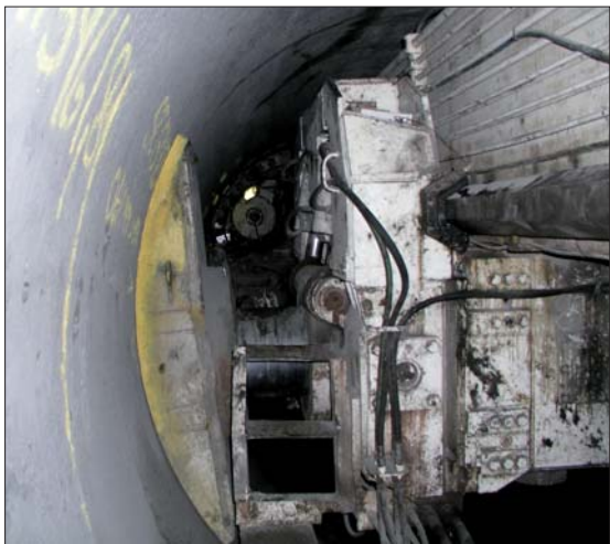
En av spennsyndrene mot sideveggen.
