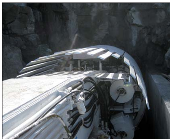
Klar til boring. Med tillatelse av J.C.
