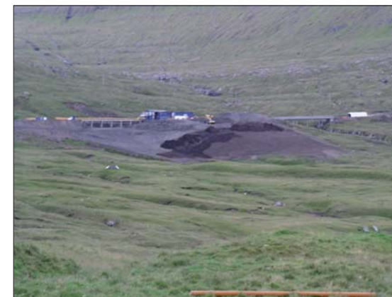
Anleggsriggen med fasiliteter og berghald. Sistnevnte jordekkes.
