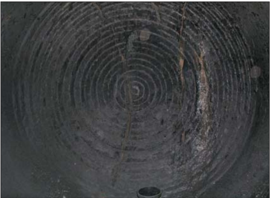
Borhullets «bunn» med spor etter bore-segmentene. Se bøtte nederst som målestokk.
